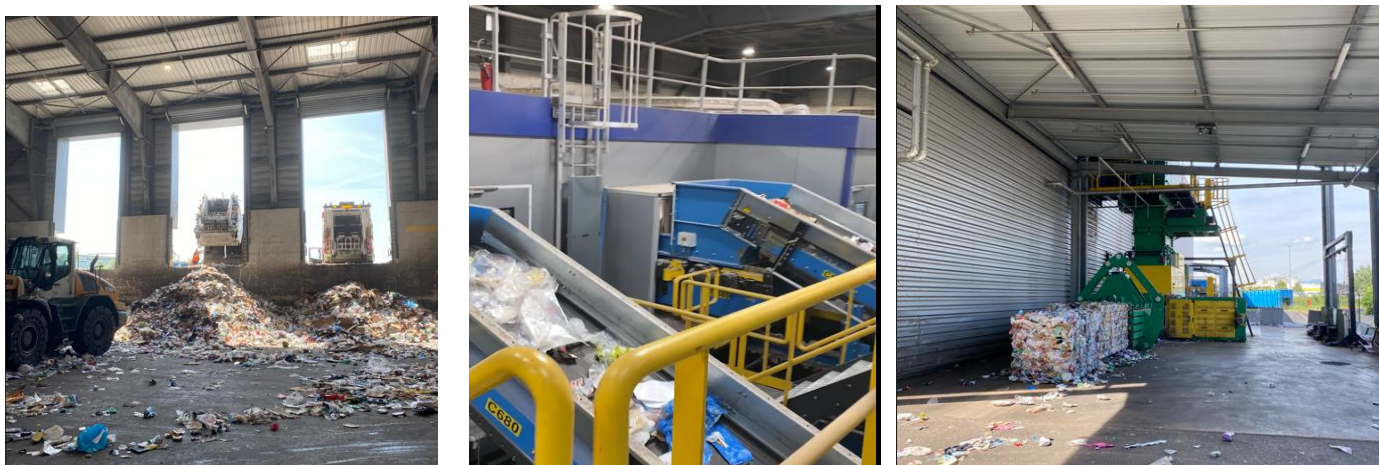
(Figure 21 : Photos du centre de tri Nicollin à Saint-Fons.
